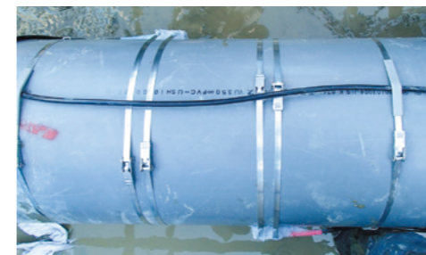
農業用水用配管(350mmφ)埋設取付け 型式:ISTT-D9000
